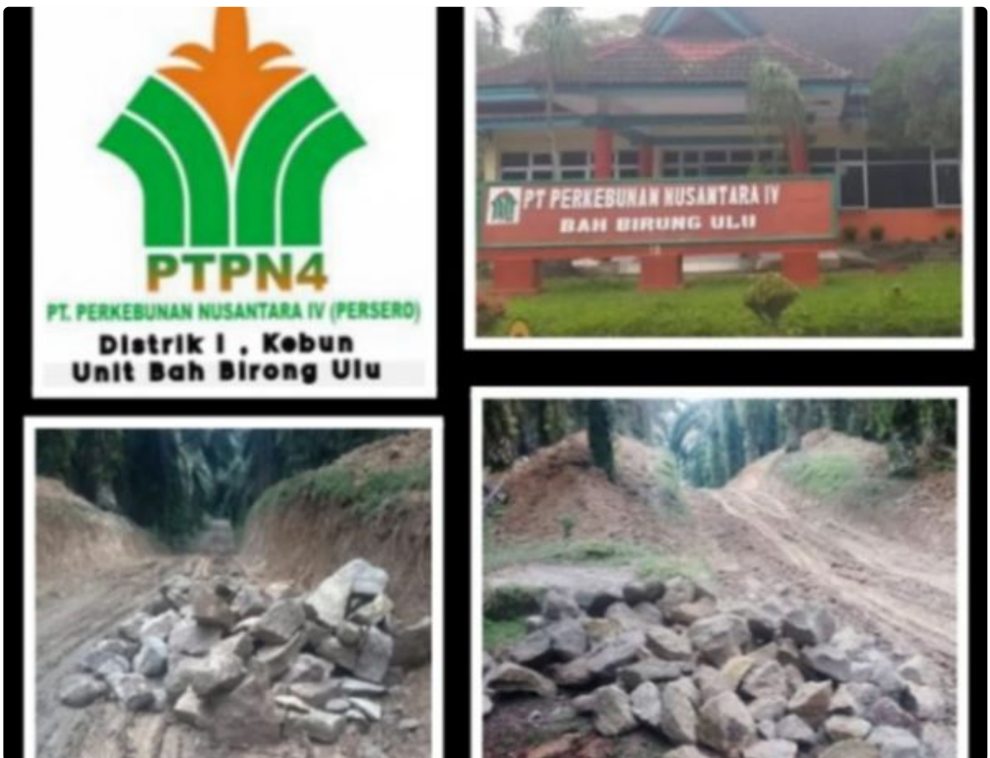
Proyek Peningkatan Jalan Produksi di PTPN IV Distrik I Kebun Unit Bah Birong Ulu, Simalungun
